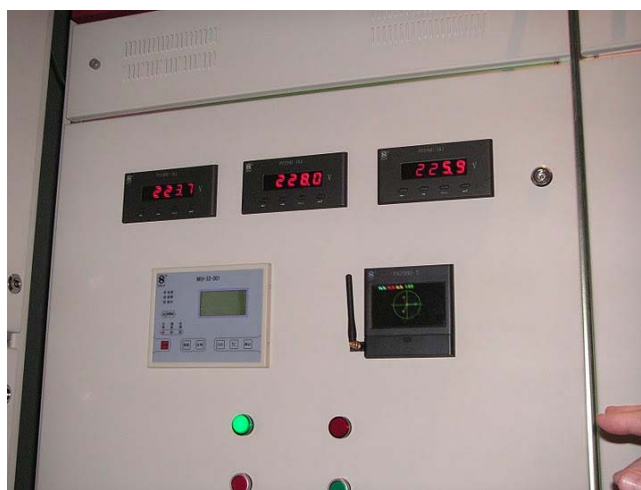
Цифровые вольтметры и многофункциональный прибор контроля качества электроэнергии
