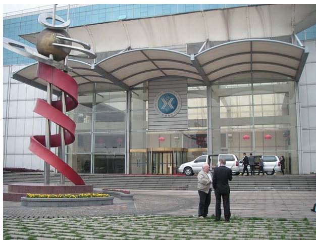
Основное здание компании Jiangsu Sferе Electric Co.
